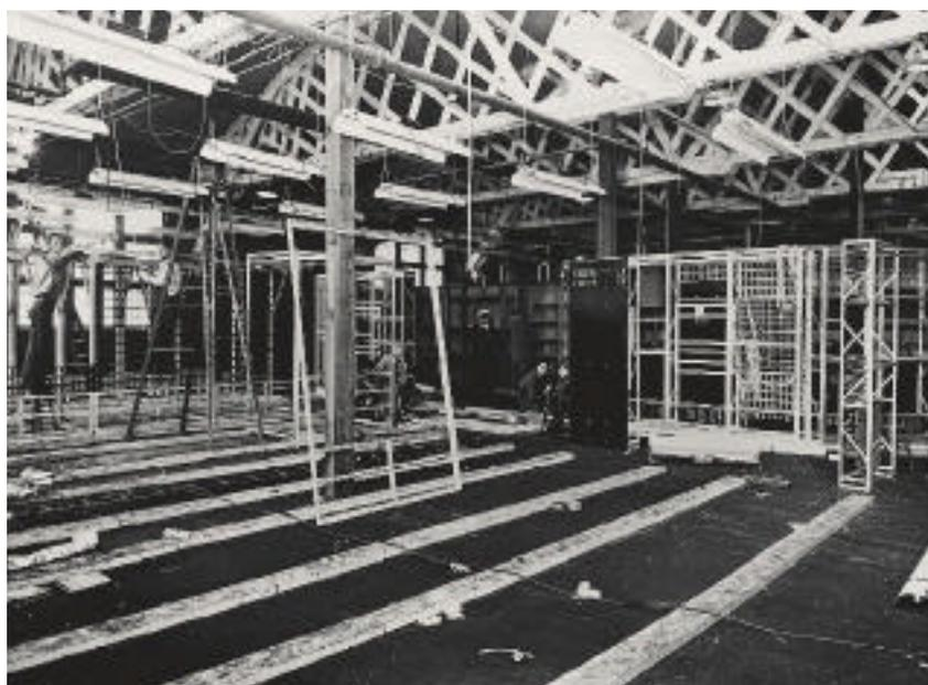
Pour abriter les éléments de l'informatique du système SAGE, il ne fallait pas moins de 70 armoires renfermant 58000 tubes à vide. Poids total : 270 tonnes !
